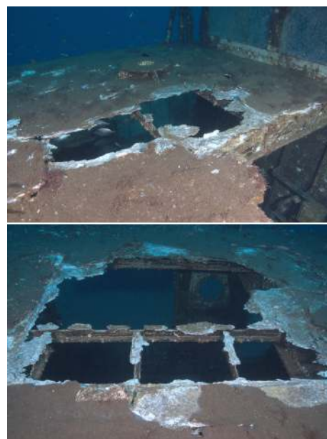
Figura 20: Aspecto dos efeitos da corrosão no RA CORCEIRA.
